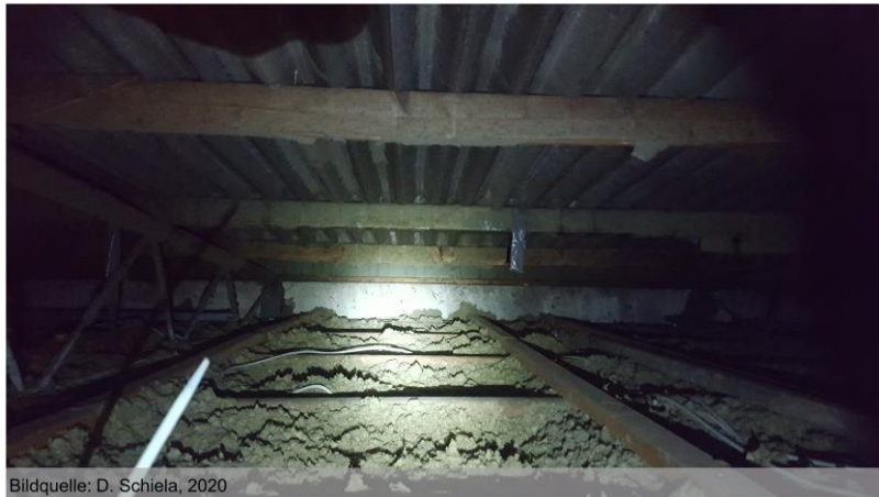
Abbildung 5: Blick in den Dachraum des nördlichen Wirtschaftstraktes
