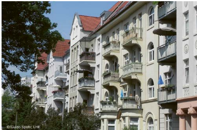
ABBILDUNG 2: Luftbild mit markierter Grenze des Reallabors und Gründerzeitgebäude der Erfurter Oststadt.
