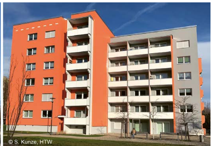
ABBILDUNG 6: Gebäude der industriellen Wohnungsbauserie 70 in Dresden-Gorbitz vor (links) und nach (rechts) der hitzeangepassten Sanierung.
