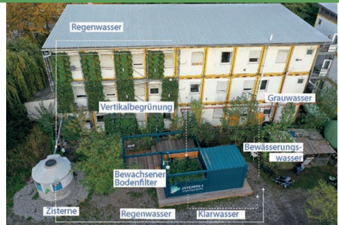
Abbildung 14: Impulsprojekt Stuttgart mit den Hauptkomponenten Zisterne, multifunktionale Pflanzenkläranlage im Container und Vertikalbegrünung. Quelle Foto: Eisenberg
