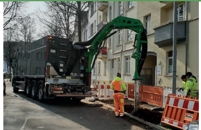
Abbildung 8: Mit dem Saugbagger werden in der Reißhausstraße Leitungen und Wurzeln vorsichtig freigelegt. Quelle: G. Spohr, LHE
